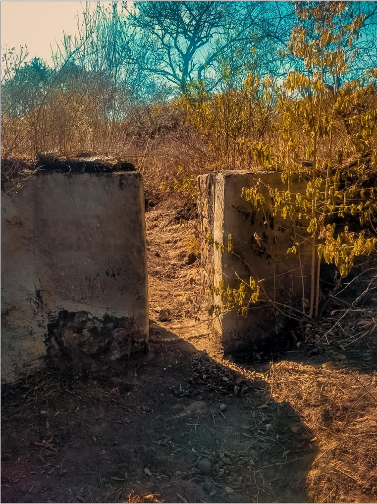
Antigua compuerta en La Loma
